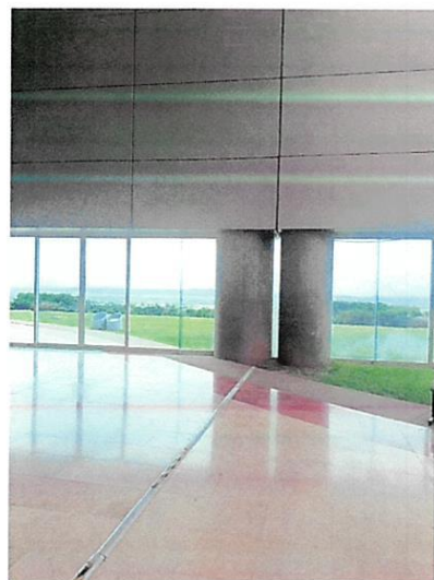
JUNTA CONSTRUCTIVA
